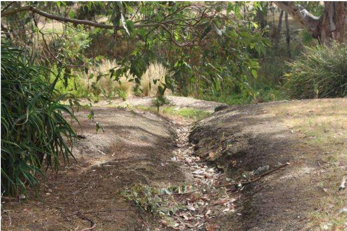
FIGURE 12 ERODING STORMWATER OUTLET, ARMYTAGE ST
