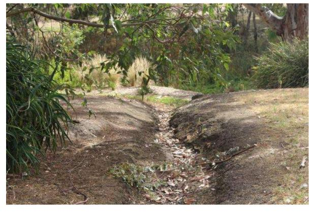
FIGURE 12 ERODING STORMWATER OUTLET, ARMYTAGE ST
